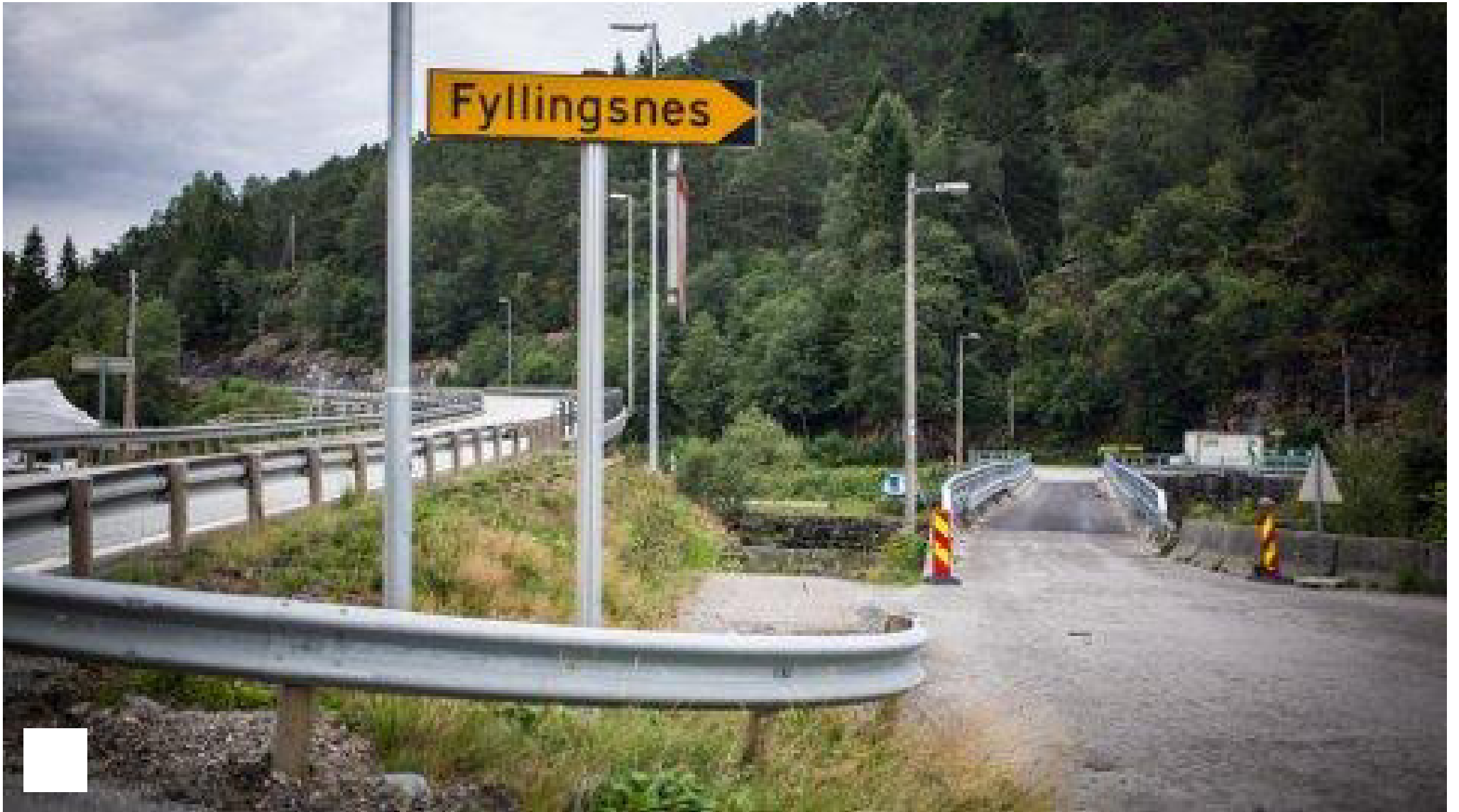
Her vart brua oppgradert - etterpa var det for trongt for bussen
