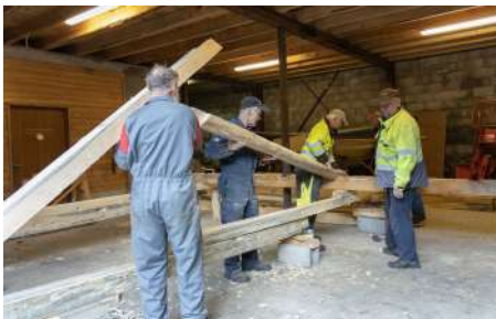
Prøvemontering av taksperr.
