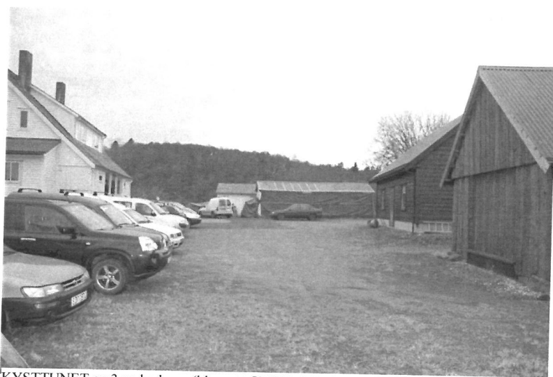
KYSTTUNET og 3 andre bygg (bl. a. ett GRINDABYGG) som er reist av Kystlaget.
