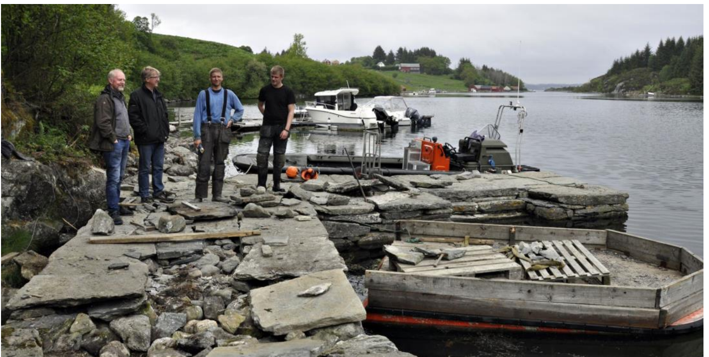
Prestebrygga under full rehabilitering med hjelpemidler og frå venstre lokalhistoriker Arnt Brakstad, artikkelforfatter Jegvan Kaarbø og to mannskap fra Haakon Aase.
